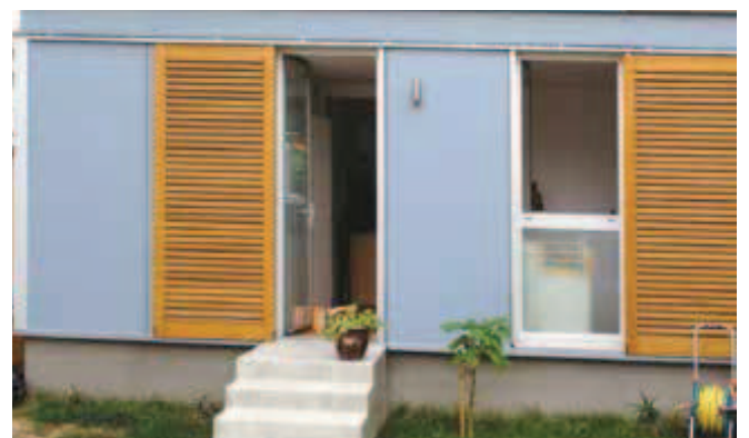
Toute l'année, ouvrez vos fenêtres en fonction de vos activités (passage de l'aspirateur, séance de bricolage, douche, bain, préparation du repas, lessive...). Une aération quotidienne de 10 minutes est recommandée.
